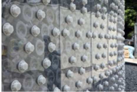
Edifici ECOARK de Taiwan
